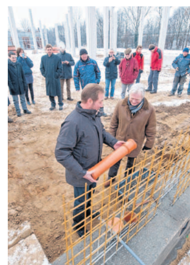
Geschäftsführer Jürgen Weiß (l.) und Bickenbachs Bürgermeister Günter Martini legten gemeinsam den Grundstein.
