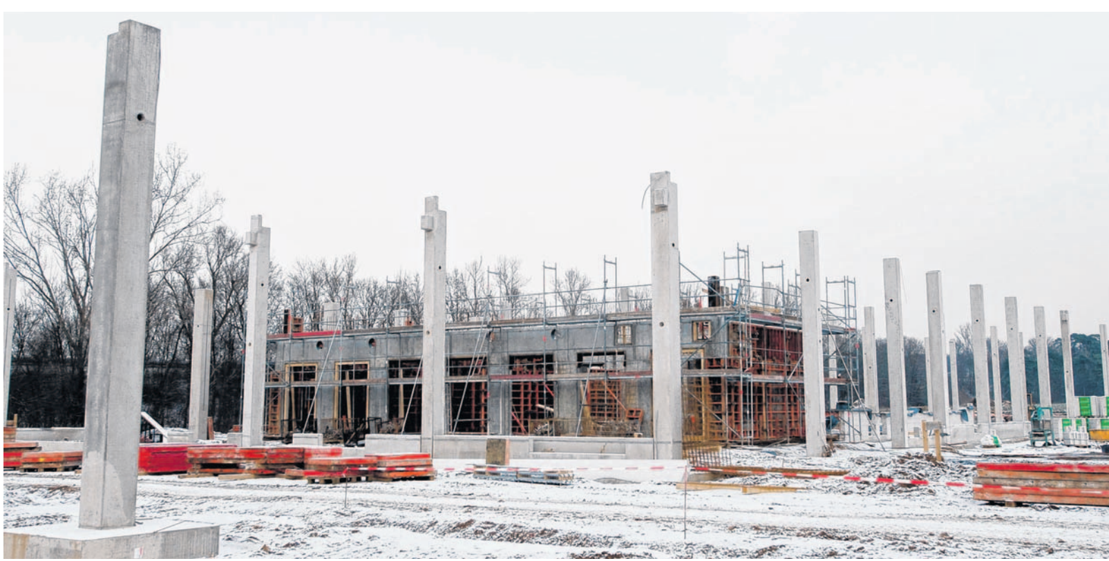
An der Berta-Benz-Straße 111 in Bickenbach – nur wenige hundert Meter vom Anschluss an die Autobahn A5 entfernt – legte die Rodauer Firma Weiß gestern den Grundstein für ihr neues Service-Zentrum für Transport- und Logistikbehälter.
